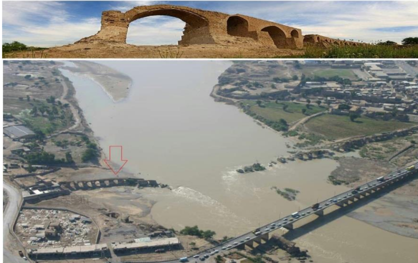
تصویر ۲. نمایی از پل بند قیصر (آرشیو میراث فرهنگی خوزستان)
