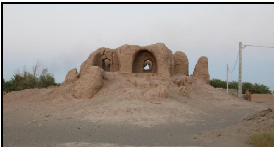
تصویر ۵: نمای ضلع غربی قلات اسلام آباد (فاضل، ۱۳۹۴، ۹۴۳؛ تصویر ۱۳۷-۱) اتاق مرکزی به شکل مربعی با ابعاد ۴/۷۰ \times ۴/۷۰ متر است. پوشش این فضا به طور کامل فرو ریخته و اطلاعی از آن در دست نیست. در اضلاع شرقی و غربی اتاق مرکزی دو
