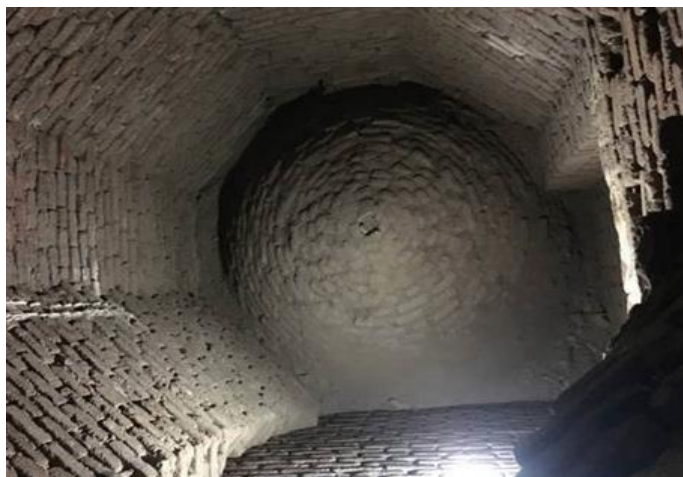
شکل ۲. نمایی از روی پوش دوم گنبد بعد از پاک‌سازی سطح آوار روی آن (همان، ۱۳۹۹)
