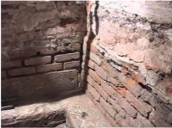
شکل ۶. اتصال دیوار شرقی مقبره به بدنه
