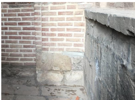
شکل ۴. امتداد ازاره دیوار شمالی حرم‌خانه که دیوار الحاقی جنوب غربی مقبره به آن متصل است (همان)
